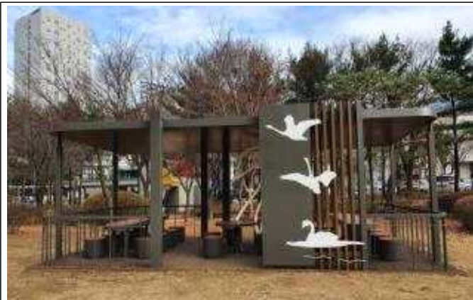
신장근린1호-티하우스 등 편의시설 설치
