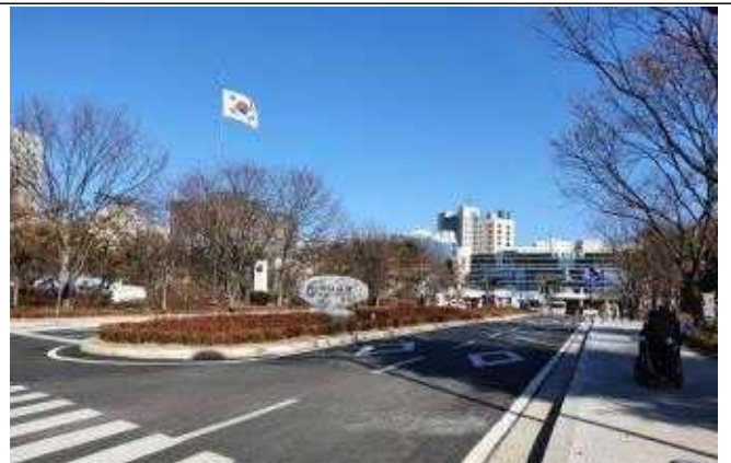
신장근린1호-보도설치 및 진입로정비
